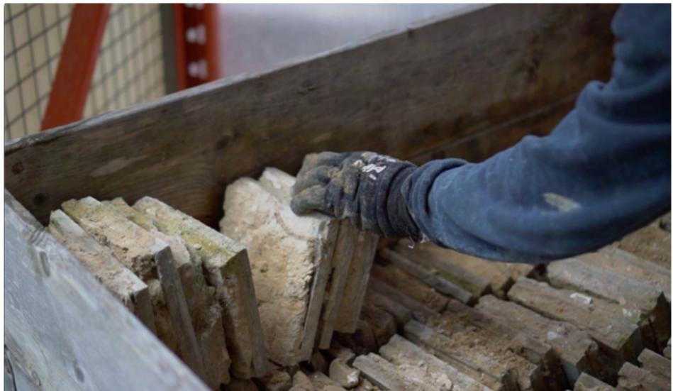
**FR** - Nous découpons mécaniquement les résidus de mortier sur la face inférieure du carreau pour faciliter sa réinstallation.
